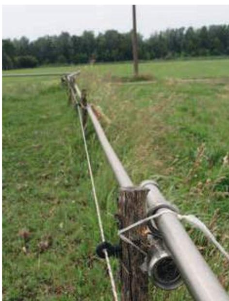
**Foto 2 -** Recinzione elettrificata perimetrale con pali in castagno e conduttore a corda abbinato a barriera fisica.
